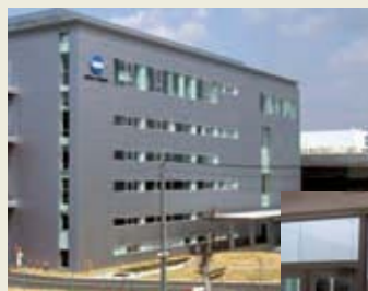
大阪狭山新棟
